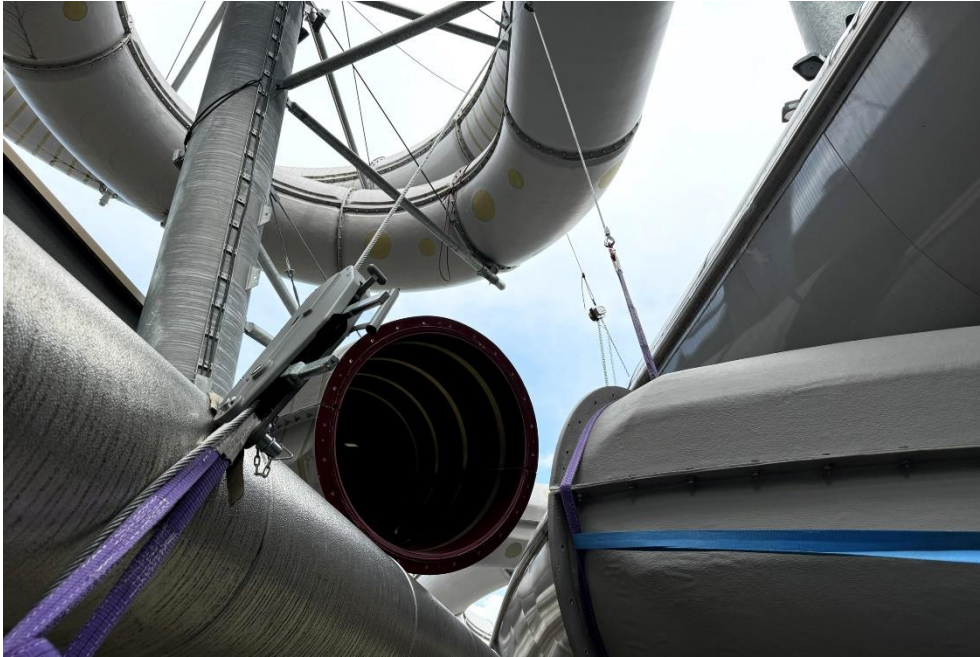
Stück für Stück werden die neuen Rutschbahnen zusammengefügt.
