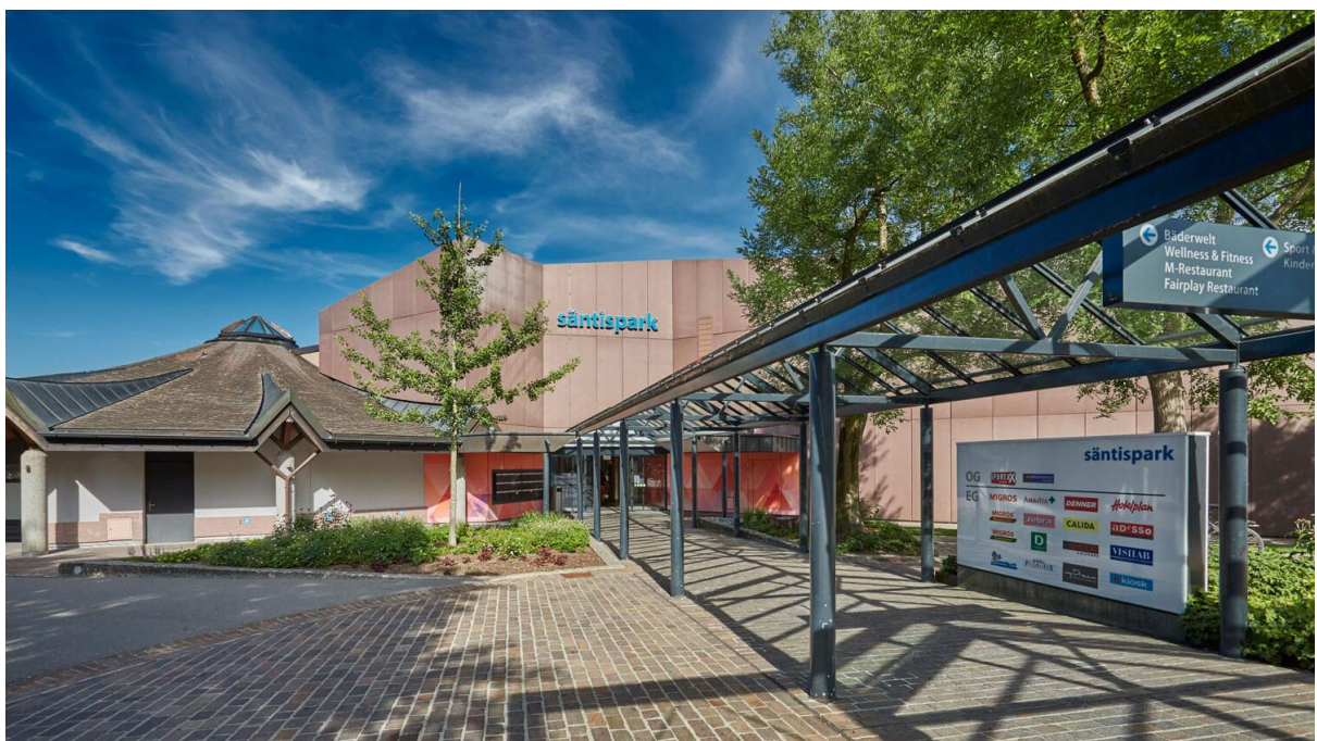
Das Einkaufszentrum Sântispark wird modernisiert.
